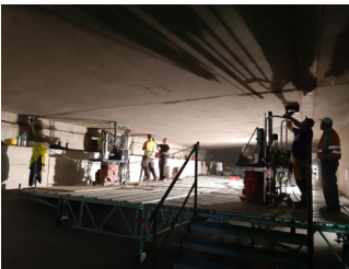
Zu erkennen sind die Bohrungen in der Fahrbahn. Hier werden etwa 15.000 Bohrungen vorgenommen, in die anschließend Verbundanker eingeklebt werden. (Quelle: BUNG Baumanagement GmbH)
