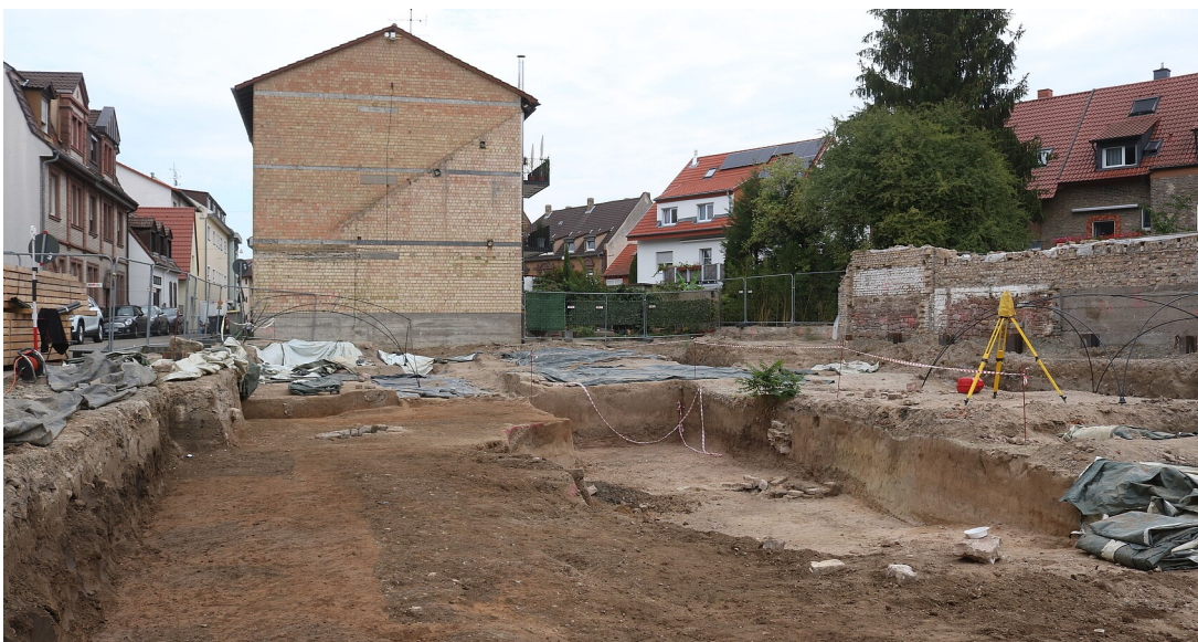
Blick auf die Grabungsfläche
