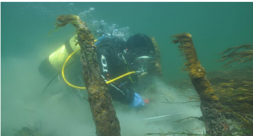
Arbeiten unter Wasser
