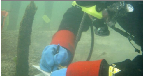
Arbeiten unter Wasser
