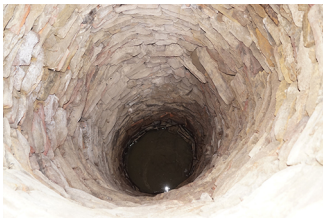
Blick in den Brunnen zwischen Katharinenstraße 8 und 10 (Foto: ArchaeoConnect)
