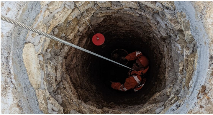
Blick in den Brunnenschacht
