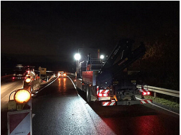
Abbau der Verkehrssicherung an der Egelseebrücke (Foto: RPS)
