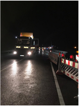
Abbau der Verkehrssicherung an der Egelseebrücke (Foto: RPS)
