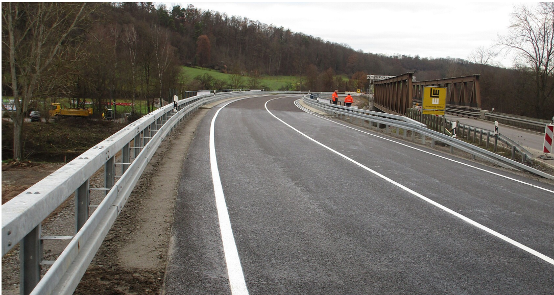
Die Egelseebrücke kurz vor der Freigabe (Quelle: RPS)
