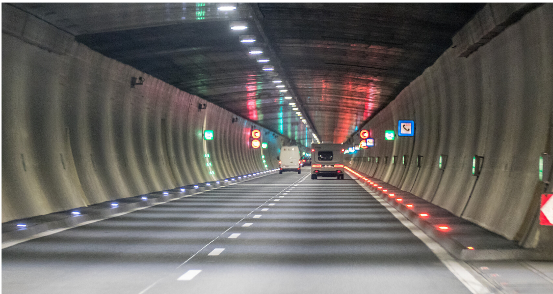
Blick in einen Straßentunnel
