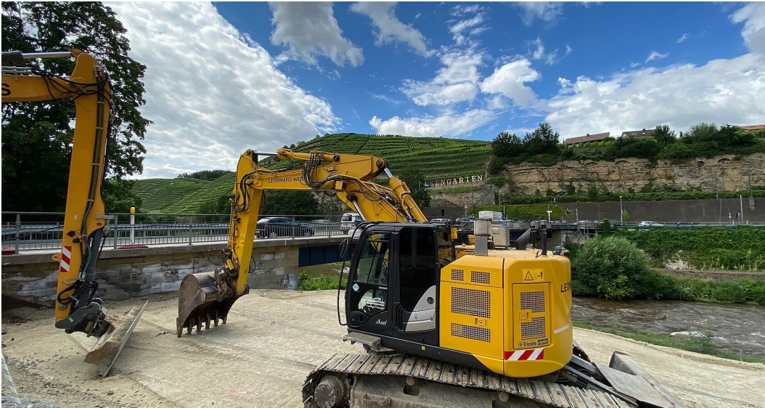
Bild zeigt Bagger beim Bau der Radwegunterführung
