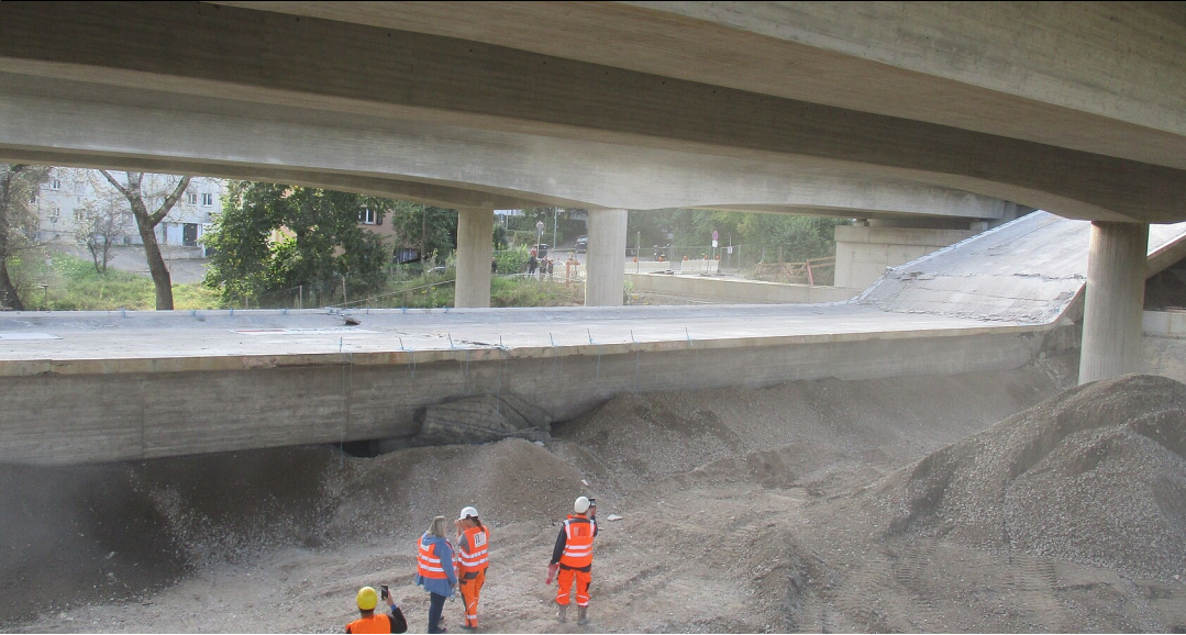
Der östliche Teil der Gumpenbachbrücke nach der Sprengung
