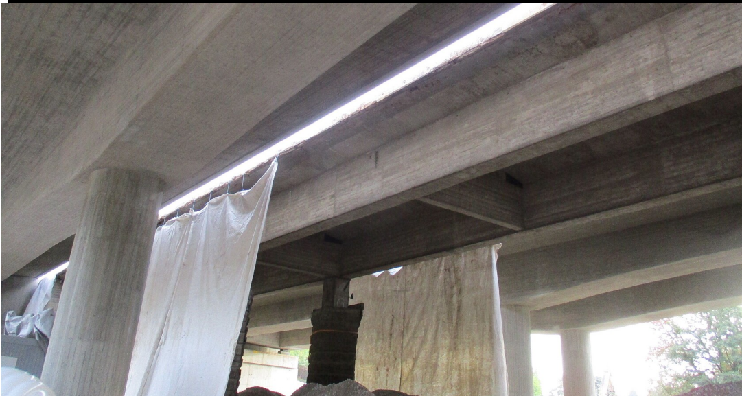
Der östliche Teil der Gumpenbachbrücke vor der Sprengung
