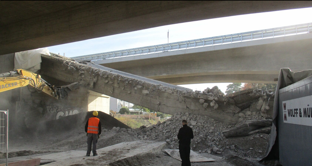
Die gesprengte Brücke wird abgebrochen
