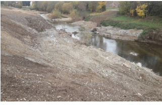
Bermvorschüttungen rechtsseitig, Foto: RPS
