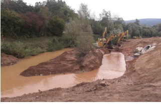
Während der Baumaßnahme, Foto: RPS
