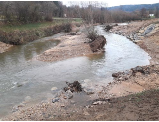
Kurze Zeit nach der Fertigstellung, Foto: RPS
