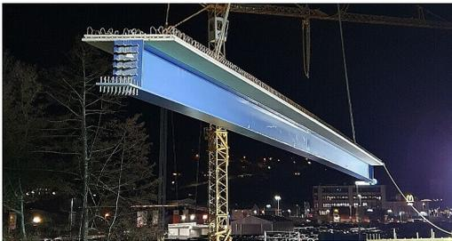
Fertigteilträger für die ersten beiden Brückenfelder werden eingehoben.
