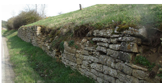
Natursteinwand vorher; Quelle: Regierungspräsidium Stuttgart
