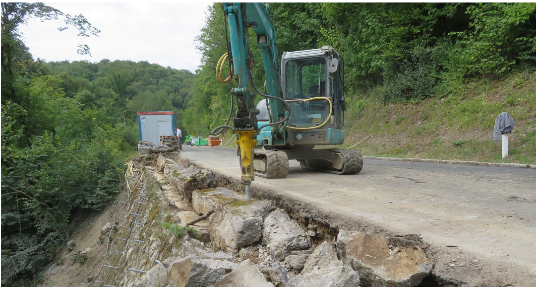
Abbruch alter Betonbalken
