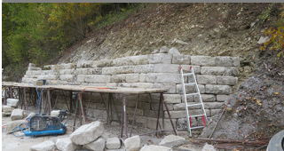
Bau der Trockenmauer
