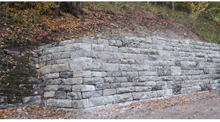
Trockenmauer Endzustand
