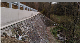
Bodennägel Endzustand
