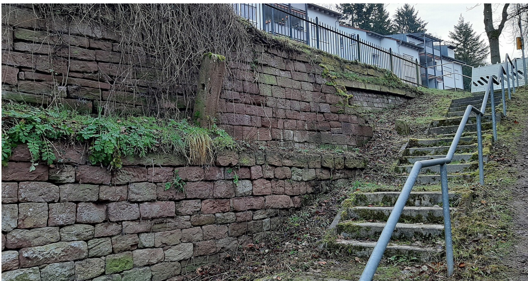
Zustand Fußgängerweg vor der Maßnahme
