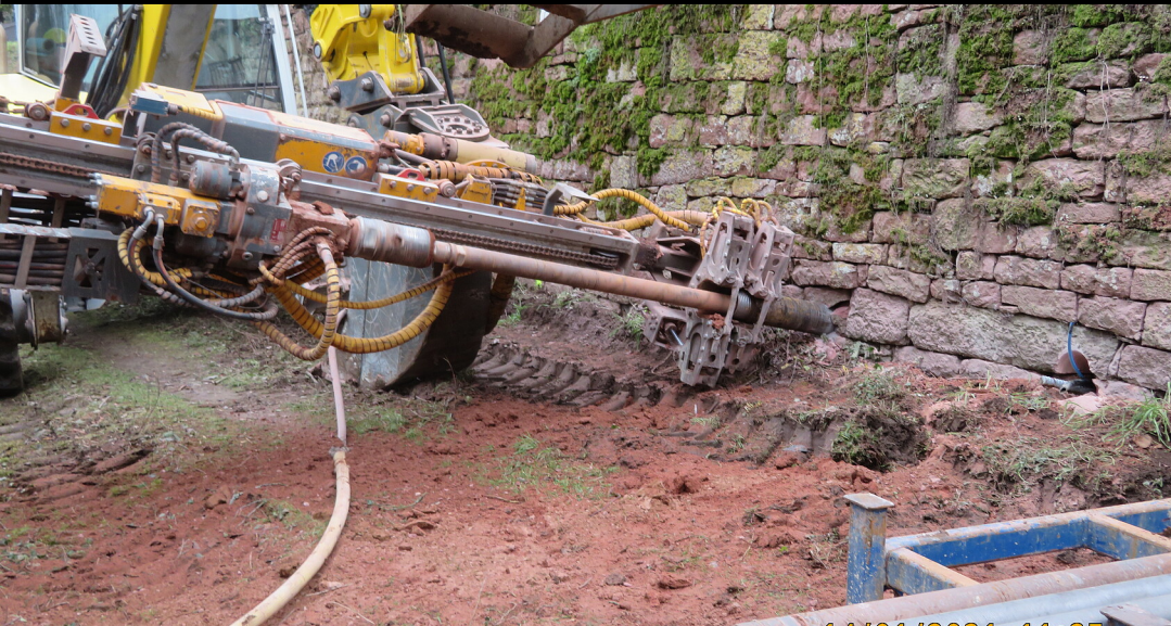
Herstellung der Bohrlöcher
