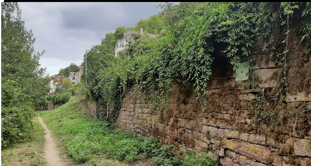
Zustand Fußgängerweg vor der Maßnahme
