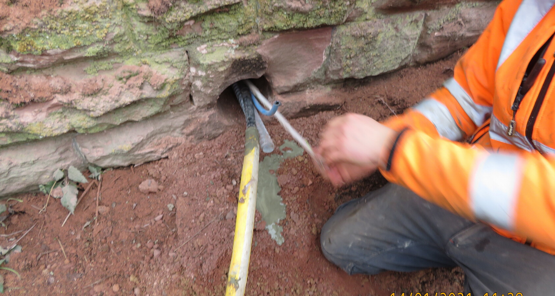
Verpressen der Bohrlöcher mit Zementsuspension
