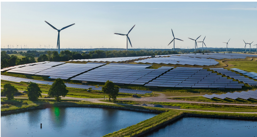
Wasserkraftwerk, Photovoltaikanlage, Windräder
