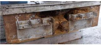
*Ausgebauter Brückenmittelteil zeigt zersetztes Holz (Quelle: Ingenieurbüro Miebach)*
