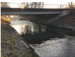
Absturz Jagstbrücke vor dem Umbau (Foto: RPS)
