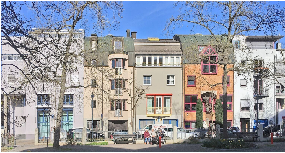
Werkbundhäuser im Dörfle (div. Architekten, 1978-92), Karlsruhe, Baden-Württemberg
