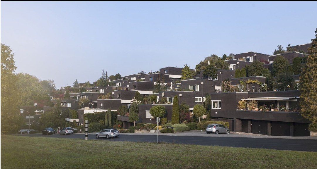
Siedlung im Schneider (Architekten Hans Kammerer, Walter Belz, 1971-72), Waiblingen, Baden-Württemberg
