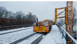
02.12.2020 Brückenprüfung an der Egelseebrücke
