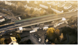
19.12.2020 Sprengung B27-Gumpenbachbrücke in Kornwestheim (westlicher Teil)
