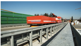
09.03.2022 Querverschub der Gumpenbachbrücke erfolgt
