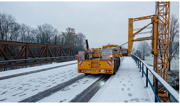
02.12.2020 Brückenprüfung an der Egelseebrücke
