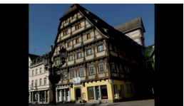
21.12.2023 ECHT VIEL HOLZ - Umnutzung eines mittelalterlichen Zollgebäudes
