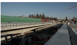
09.03.2022 Zeitraffer-Video Querverschub Gumpenbachbrücke Kornwestheim
