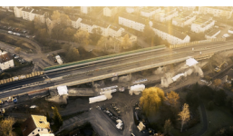
19.12.2020 Sprengung B27-Gumpenbachbrücke in Kornwestheim (westlicher Teil)
