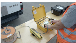
02.10.2021 Sprengung B27-Gumpenbachbrücke in Kornwestheim (östlicher Teil)
