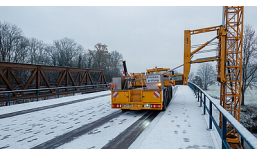
02.12.2020 Brückenprüfung an der Egelseebrücke
