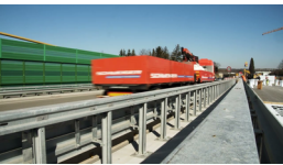
09.03.2022 Querverschub der Gumpenbachbrücke erfolgt
