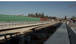
09.03.2022 Zeitraffer-Video Querverschub Gumpenbachbrücke Kornwestheim
