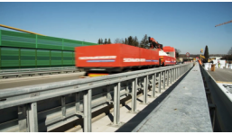
09.03.2022 Querverschub der Gumpenbachbrücke erfolgt
