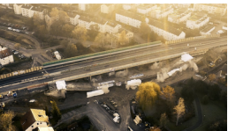
19.12.2020 Sprengung B27-Gumpenbachbrücke in Kornwestheim (westlicher Teil)
