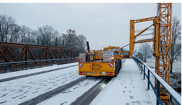
02.12.2020 Brückenprüfung an der Egelseebrücke
