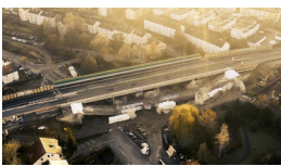
19.12.2020 Sprengung B27-Gumpenbachbrücke in Kornwestheim (westlicher Teil)
