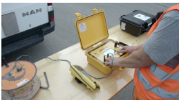
02.10.2021 Sprengung B27-Gumpenbachbrücke in Kornwestheim (östlicher Teil)
