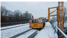
02.12.2020 Brückenprüfung an der Egelseebrücke
