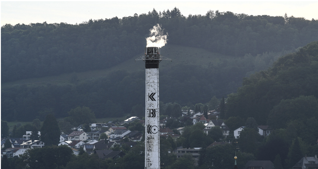
Bild zeigt den Eisenbetonschornstein
