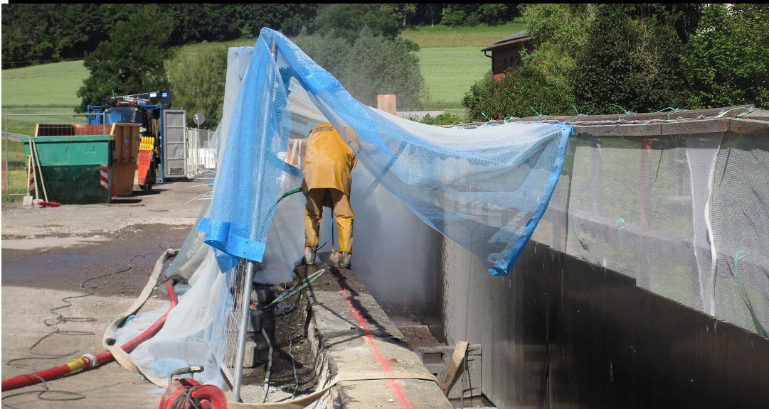
An den Kappen wurde mit einem Höchstdruckwasserstrahl gearbeitet
