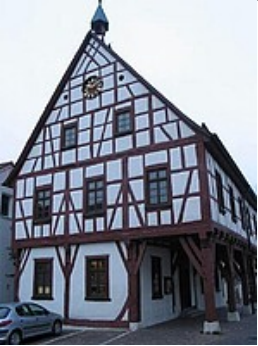
Stadtbücherei Schelklingen - Fachwerkgebäude
