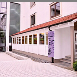
Gebäude der Gemeindebücherei Neue Schule Kirchdorf/Iller
