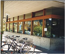
Gebäude der Gemeindebücherei Baienfurt
