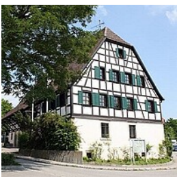
Fachwerkgebäude der Gemeindebücherei Dettenhausen im Bürgerhaus
