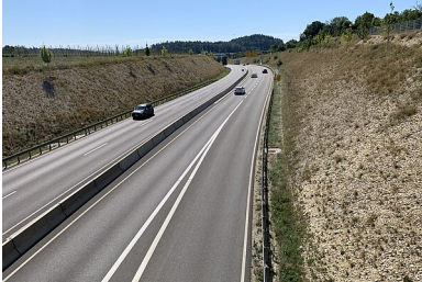
B 31n-Trasse im Bereich der Anschlussstelle Kogenbach
