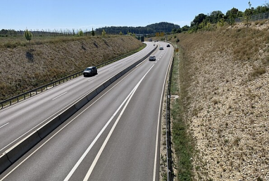
B 31n-Trasse im Bereich der Anschlussstelle Kogenbach
