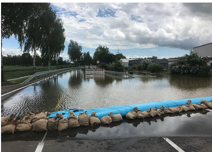
Hochwasser in der Baltringer Straße in Schemmerberg
