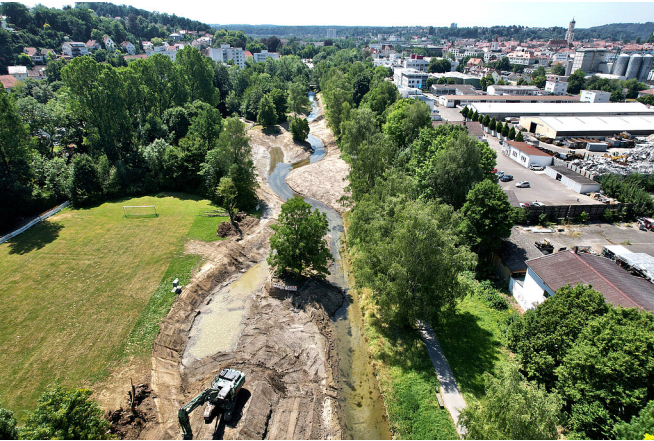
Bauarbeiten am Rißkanal in Biberach/Riß
