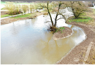
Flutmulde bei Hochwasser
