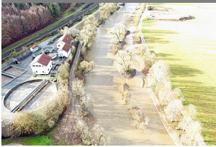
Flutmulde bei Hochwasser von oben
