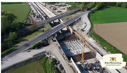
Rückblick: ? B 30 Verlegung bei Ravensburg
