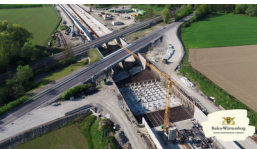
Rückblick: ? B 30 Verlegung bei Ravensburg
