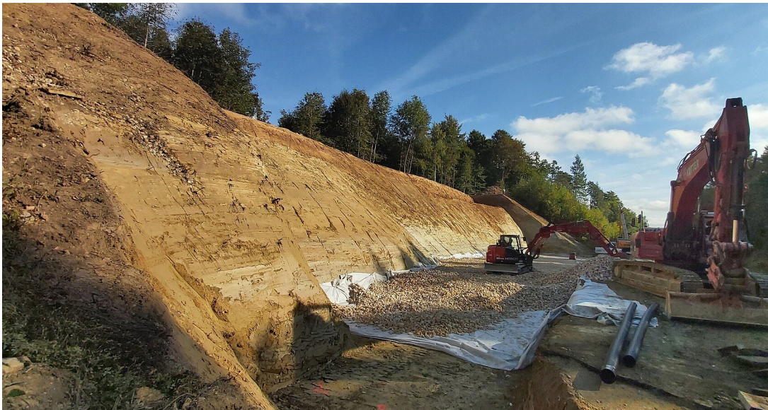
Böschungssanierung bei der B 312 zwischen Uttenweiler und Ahlen
