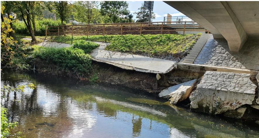
Böschung an der Echaz nach Hochwasserschaden
