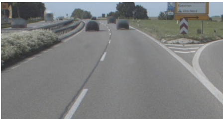
B 10 zwischen Ausfahrt Ulm-Uni und Anschlussstelle A 8 Ulm-West
