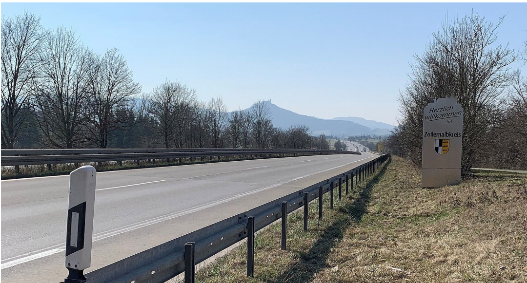
B 27 Anschlussstelle Hechingen Blickrichtung Zollernburg
