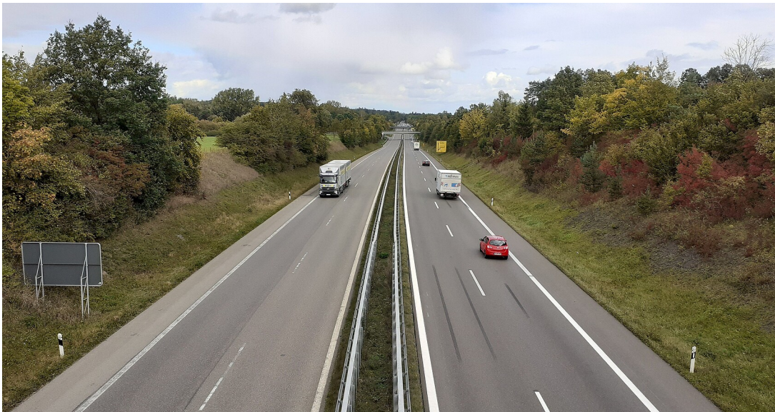
B 27 zwischen Anschlussstelle Hechingen und der Anschlussstelle Bodelshausen
