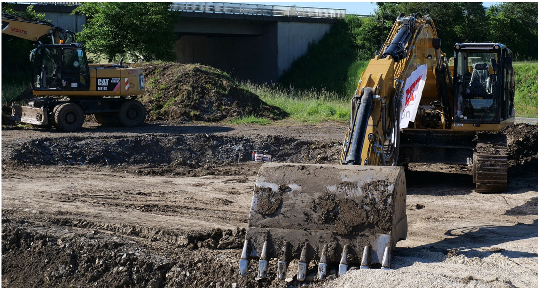
Bauarbeiten für den Kreisverkehr B 27 Anschlussstelle Hechingen Nord
