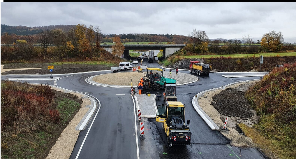
Luftbild aus der Bauzeit vom Kreisverkehr an der B 27, AS Hechingen-Nord
