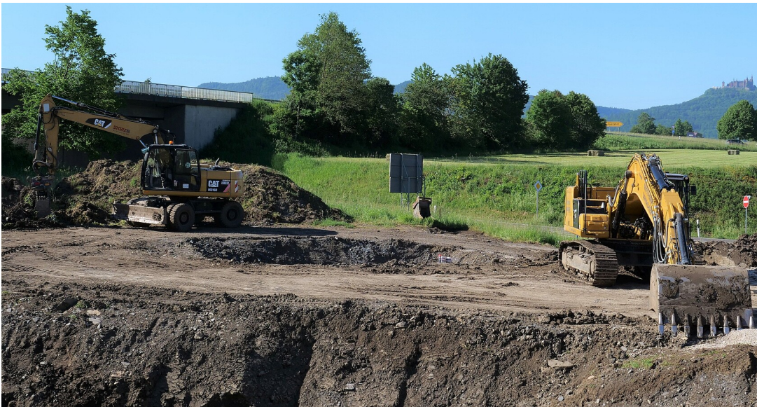
Bau des Kreisverkehrs zur Anbindung des Gewerbegebiets Nasswasen
