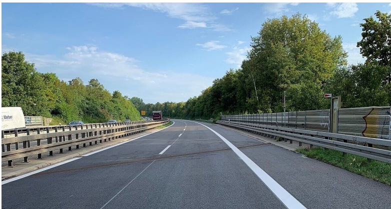
Fahrbahndeckenerneuerung der B 27 bei Pliezhausen und Walddorfhäslach
