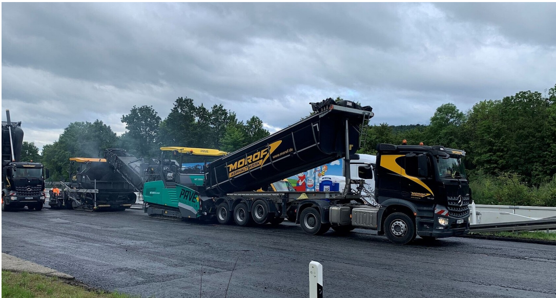
Fahrbahnerneuerung auf der B 27 zwischen Pliezhausen und Walddorfhäslach
