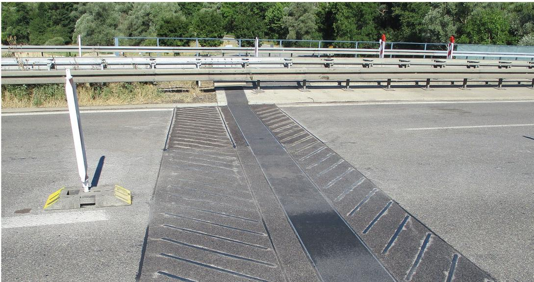
Neue Übergangskonstruktion auf der Brücke über die Wiesaz bei Dußlingen in Fahrtrichtung Tübingen
