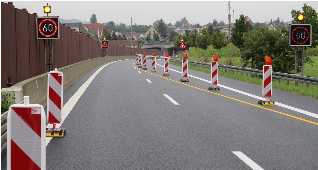
B 27 | Tunnel Dußlingen
