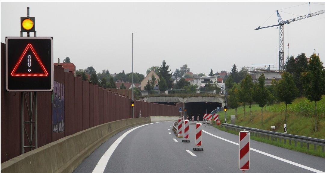
B 27 - Tunnel Dußlingen
