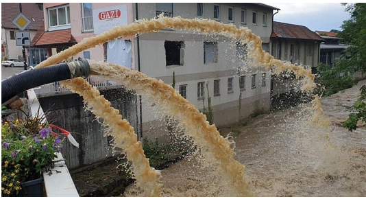
Abpumparbeiten nach dem Unwetter in Dußlingen
