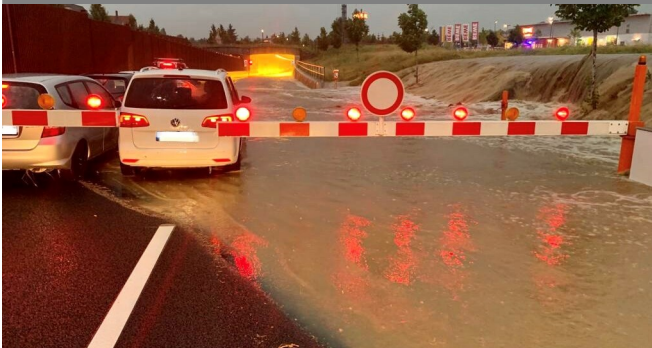
Blick in den gefluteten B 27-Tunnel in Dußlingen
