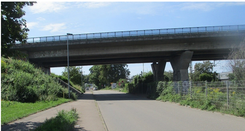
Bahnbrücke im Verlauf der L 1208 in Tübingen
