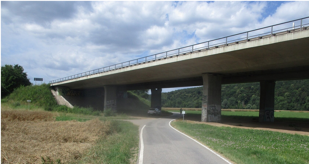
B 27 Neckarbrücke mit Neckartalradweg
