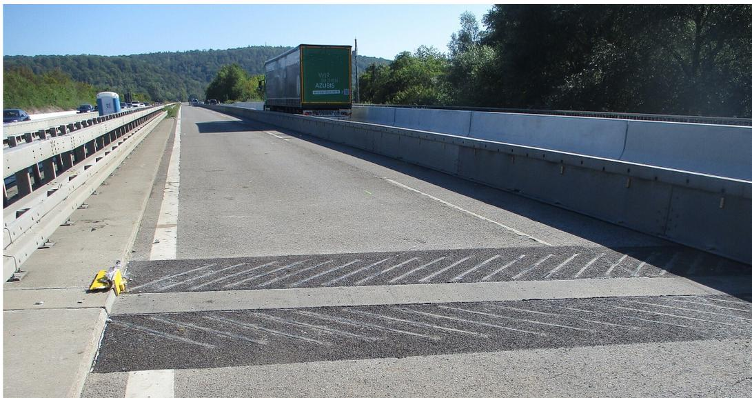
B 27 Bahnbrücke neue Übergangskonstruktion
